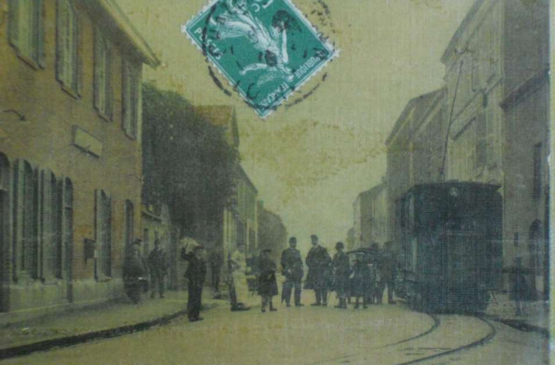
SAINT-ETIENNE - Gare du Tramway Electrique. Rue Barnousse
