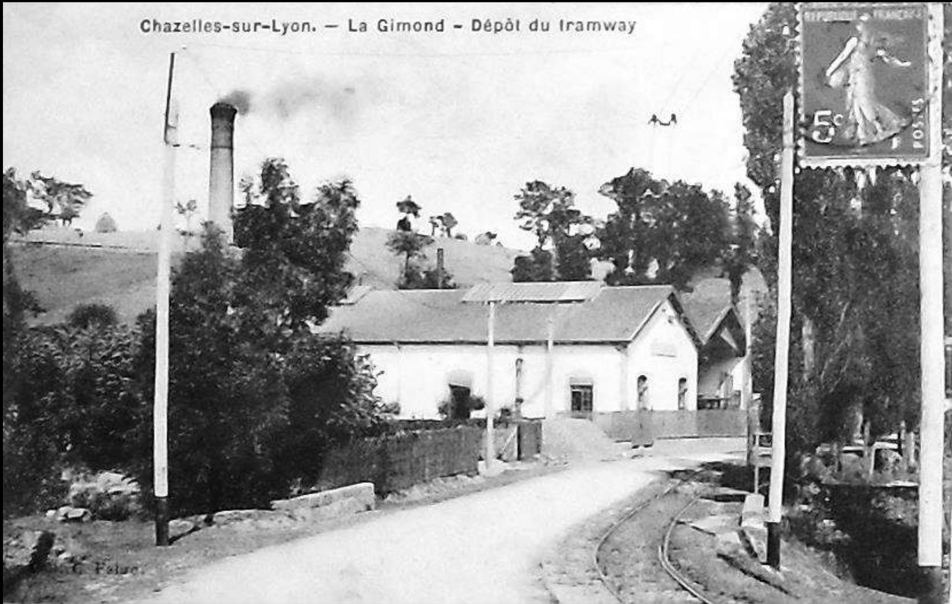
..arrive à l'usine électrique de La Gimond qui assure l'alimentation de la ligne de tramway avec des machines à vapeur faisant tourner des dynamos qui délivrent un courant de 550 V
