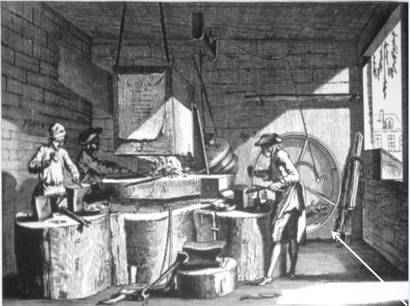
Même image d'un atelier avec roue à chien au 18 e siècle (Diderot/d'Alembert-Le cloutier)
