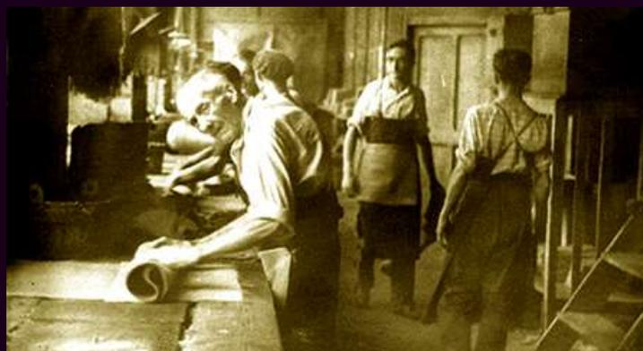
Cette dernière opération est reprise plusieurs fois avec vérification visuelle entre chaque passage. À la fin, on obtient un cône qui n'a pas beaucoup diminué en taille mais qui a une structure homogène. Il est prêt à affronter le foulage.
