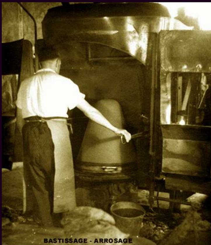
Une dépression est créée, le cône tourne, la bourre tombe et recouvre le cône d'une fine couche. La dépression cesse, le bastisseur ouvre alors les portes et lance l'aspersion du cône qui continue de tourner. La fine couche de poils ainsi humectée va résister au démoulage.
