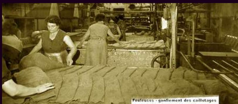
On passe ensuite au foulage proprement dit avec une vitesse de va et vient latéral plus rapide et le passeur surveille l'avance du feutrage ainsi que sa régularité. Il peut pallier aux imperfections – trop ou pas assez de feutrage en tête ou en flanc – en jouant sur la présentation des cônes à l'entrée dans la fouleuse.
